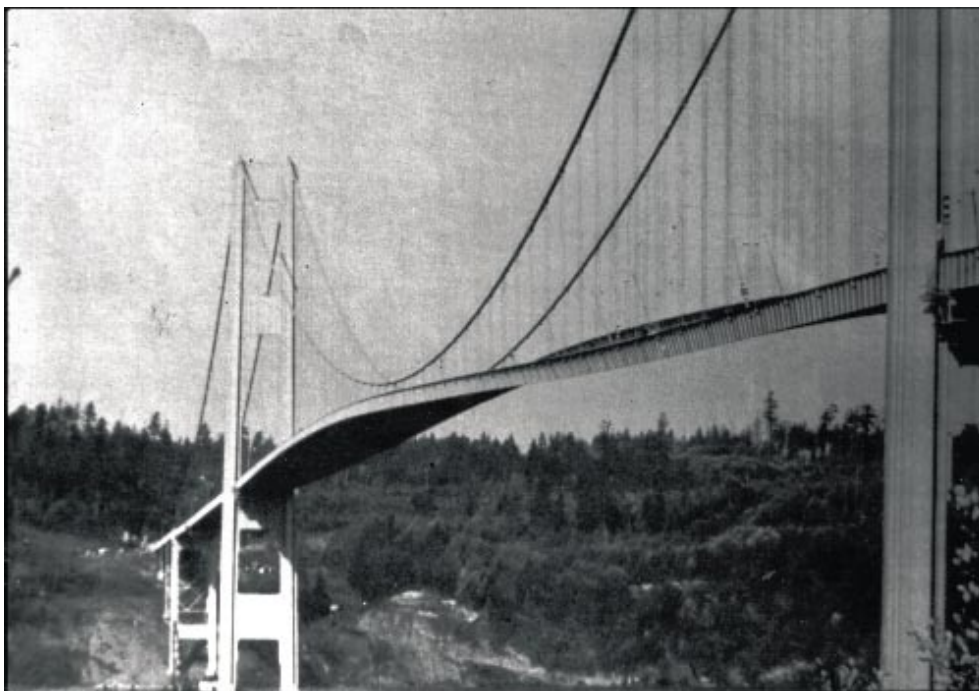
Abb. 9: Die schwingende Tacoma-Brücke.
